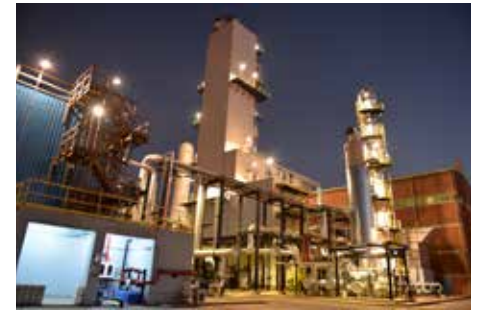
Erdemir'de 7. Hava Ayrıştırma Tesisi, 2015 yılında üretime başladı.
